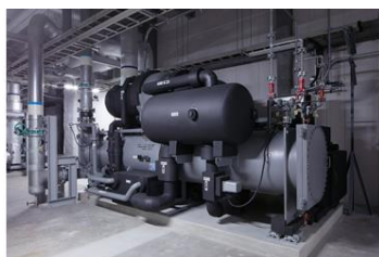
【スクロールターボ冷凍機 (BRE-1)】
